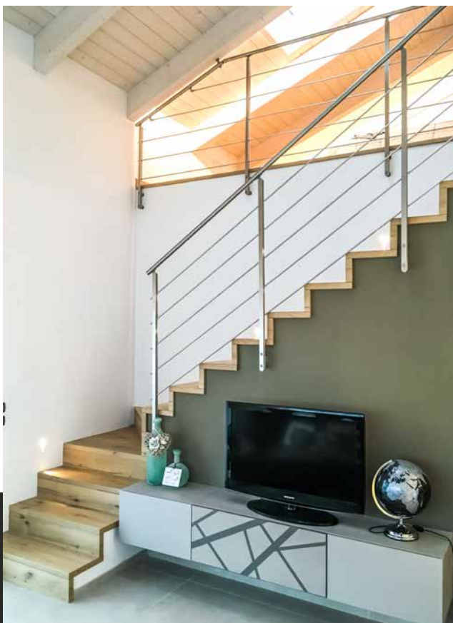
Rivestimento di legno ROVERE con pedata ed alzata su scala in cemento, ringhiera in ACCIAIO INOX SATINATO con montanti a doppia lama, n° 05 elementi inclinati e paralleli tra loro passanti all'interno.
