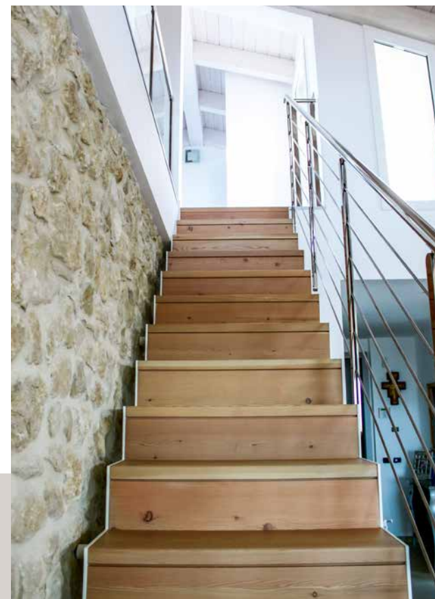
Scala al LASER composta da struttura doppia in lamiera di metallo con taglio " A SALTARELLO ", scalini ed alzate in legno LARICE . Ringhiera con elementi inclinati in ACCIAIO INOX , balausta di protezione in ACCIAIO INOX e VETRO .
