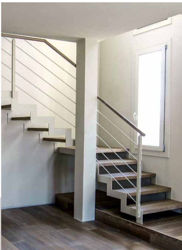
Scala al LASER composta da struttura doppia in lamiera di metallo con taglio " A SALTARELLO ", scalini eseguiti con la composizione di listoni di pavimento. Ringhiera con elementi inclinati in metallo verniciato.
