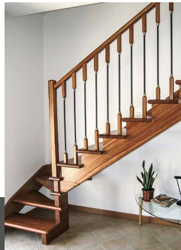
Scala completamente in legno essenza DOUSSIÈ con struttura a muro a fascia e posta sotto lo scalino a vista, ringhiera classica con elementi verticali.
