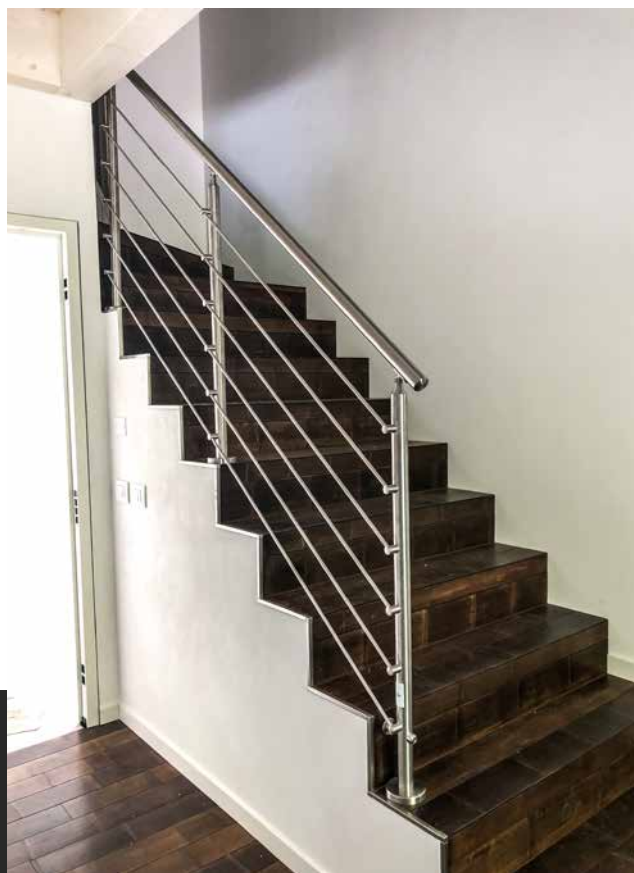
Ringhiera in ACCIAIO INOX SATINATO con montanti circolari, n° 06 elementi inclinati e paralleli tra loro passanti esternamente al montante con accessori.
