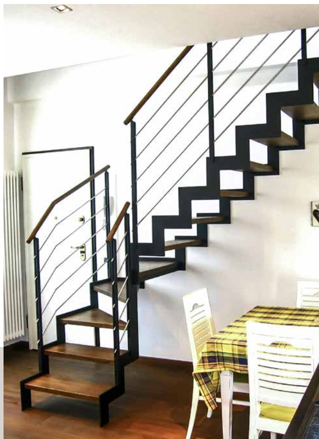
Scala al LASER composta da struttura doppia in lamiera di metallo con taglio " A SALTARELLO ", scalini in legno ROVERE . Ringhiera con elementi inclinati in metallo, acciaio inox e legno.
