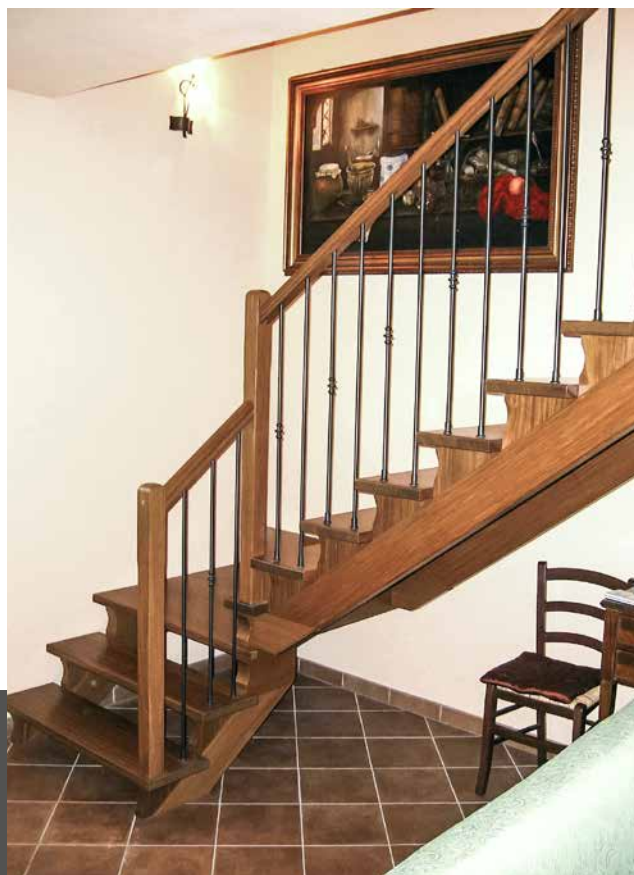
Scala completamente in legno essenza AFRORMOSIA con struttura doppia posta sotto lo scalino, ringhiera classica con elementi verticali.
